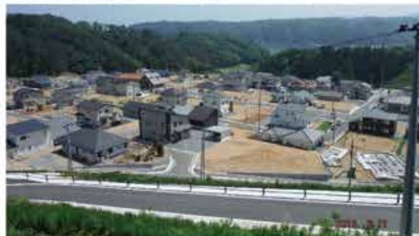
写真2 造成完了の9ヶ月後（平成28年6月11日）
