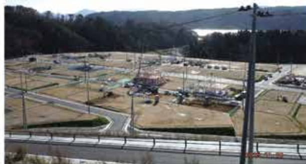
写真1 造成完了の1ヶ月後（平成27年11月16日）
