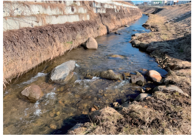
図9 分水路流路多様化試験
