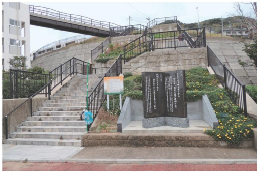
写真2 傾斜地に集落があるので左奥にある公営住宅のエレベーターを利用してだれでも坂の上に行けるように配慮している。
