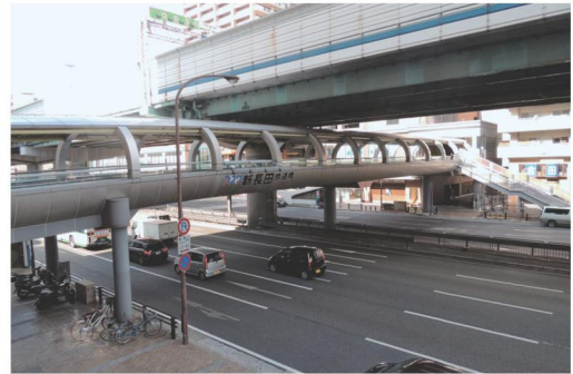
写真5 駅から国道をはさんだところで商店街(低層部分)と住宅(高層部分)がある。歩道橋などで連続性を確保し、地区一体を整備している。
