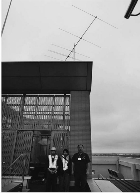
図2 県立久慈病院屋上でのアンテナの設置
