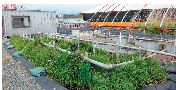
写真1 花巻の人工湿地排水処理システム
