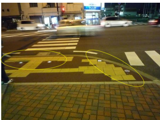
写真 1 1 自発光鉾<試作>の設置状況
