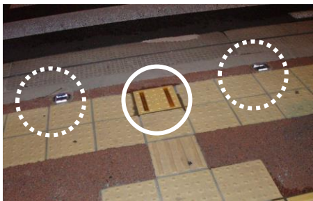
写真 6 道路鋲(点線円 左・右) 自発光型点状ブロック(警告用)(実線円 中央)
