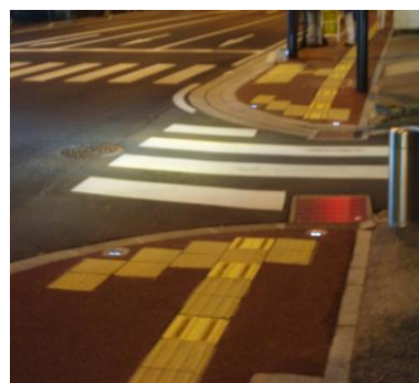
写真 5-2 実験場所の状況(夜間時)
