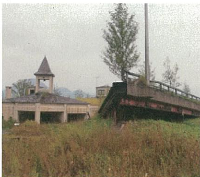
写真4 洞爺湖温泉 泥流によって破壊された公共温泉施設と橋。
