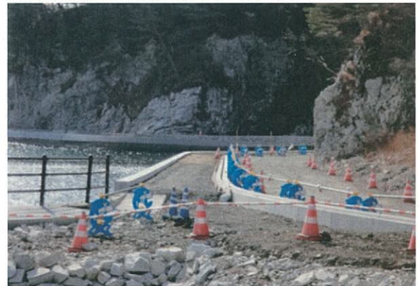
復旧工事中の浄土ヶ浜の道路
