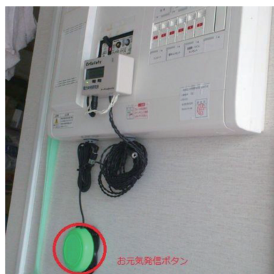
図1：実験協力者宅の分電盤総に負荷電流の測定器（電力中央研究所）を設置している状況（釜石市鶴住居町仮設住宅、2012/7/17）
