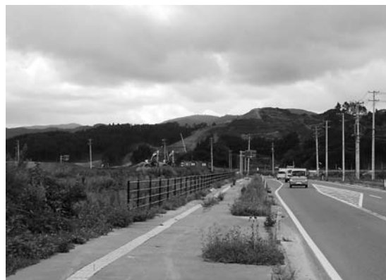
写真1 高台造成が進む陸前高田市今泉地区 (2013年9月筆者撮影)
