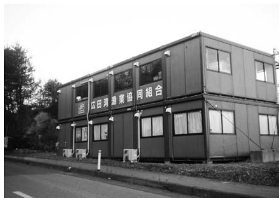
写真2 広田湾漁協（仮事務所）
