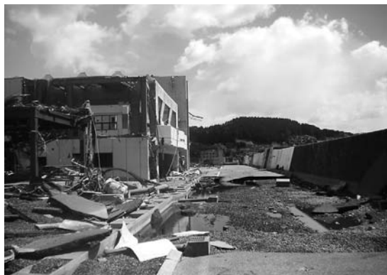
写真12 宮城県漁協志津川支所（全壊）
